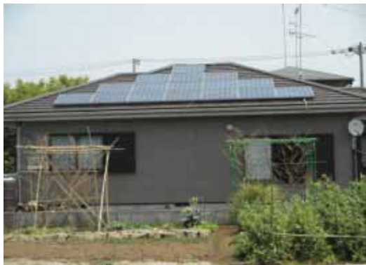
愛川町の住宅 緑のカーテンと太陽光パネル
