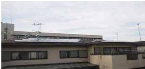
厚木市上依知の住宅に設置した3.4kWシステム
