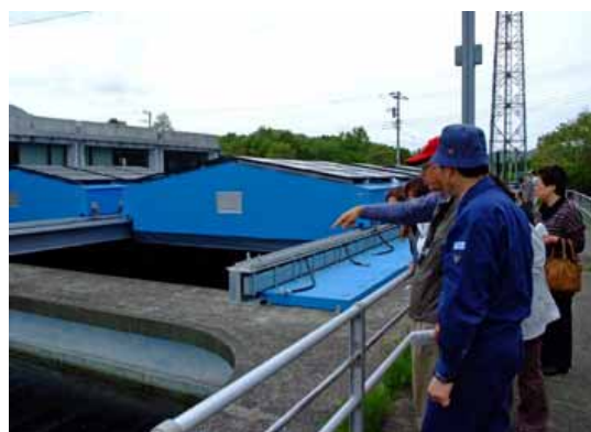
ろ過池では砂、砂利を通り水道水となる
