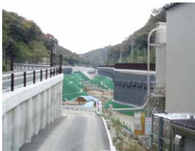
ごみ最終処分場（かながわ環境整備センター）
